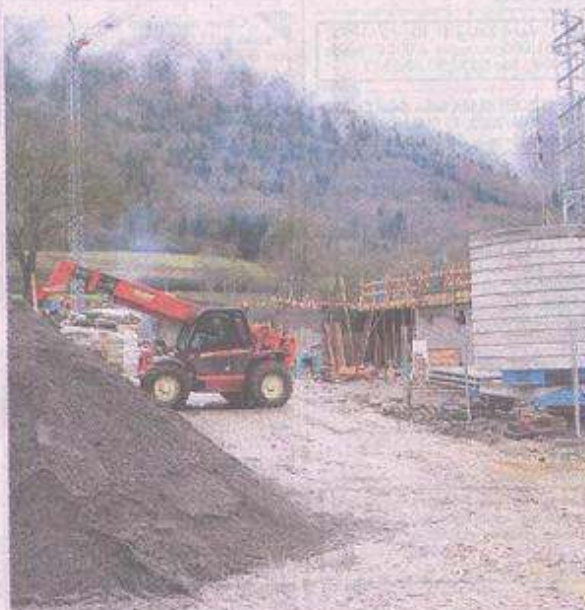
La résidence de tourisme Les Trois Vallées sort de terre à Arreau. Photo DDM, Gérard Latour
